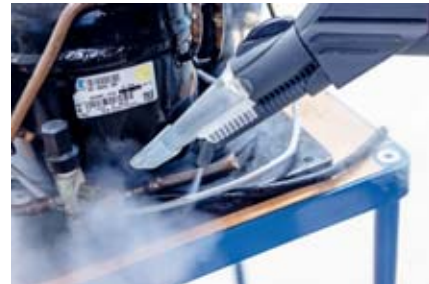
Saubere Leitungen minimieren den Wärmeverlust und Strombedarf.
